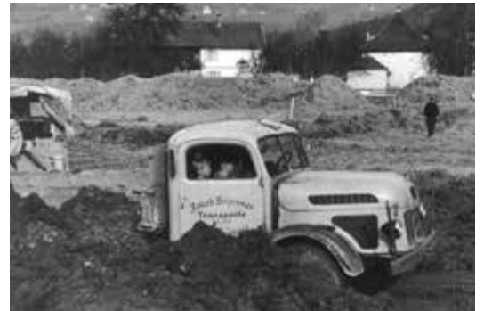
Bei der Vergabe der Aufträge wurden Rankweiler Unternehmen – wie hier das Fuhrunternehmen Jakob Branner – besonders berücksichtigt.
