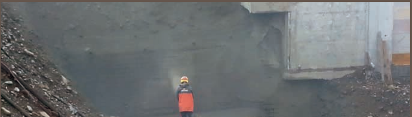
Sicherung mit Spritzbeton
