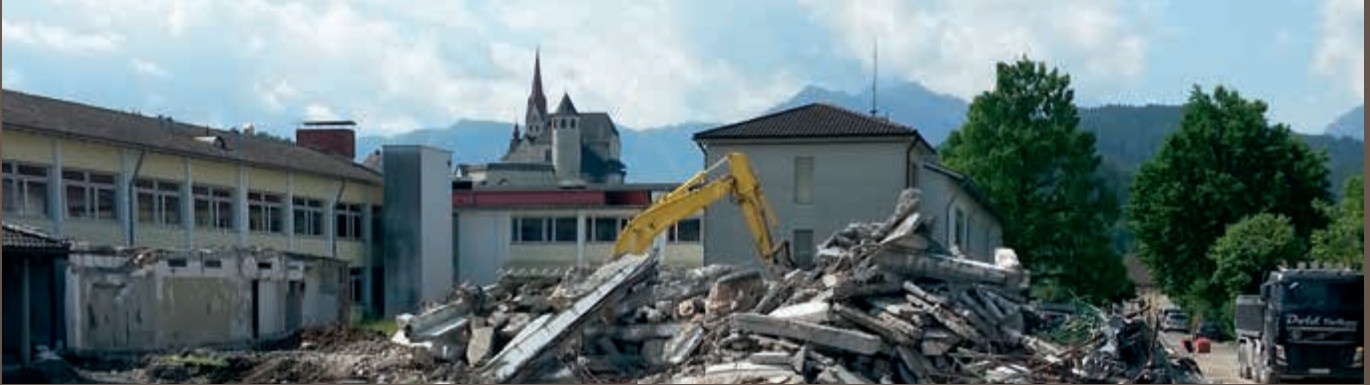
Abbruch des alten Bestands
