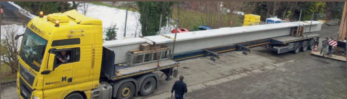
Lieferung der Dachträger
