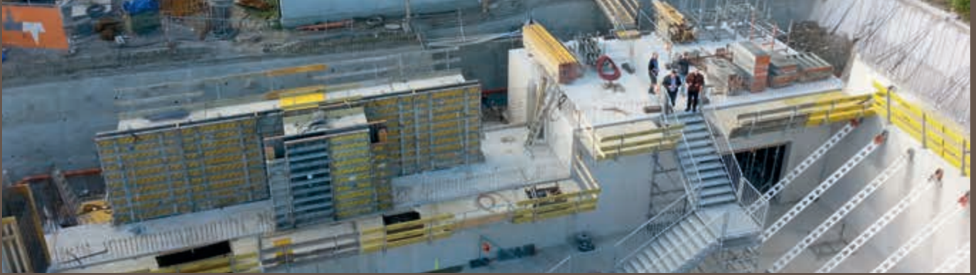
Arbeiten am Untergeschoss
