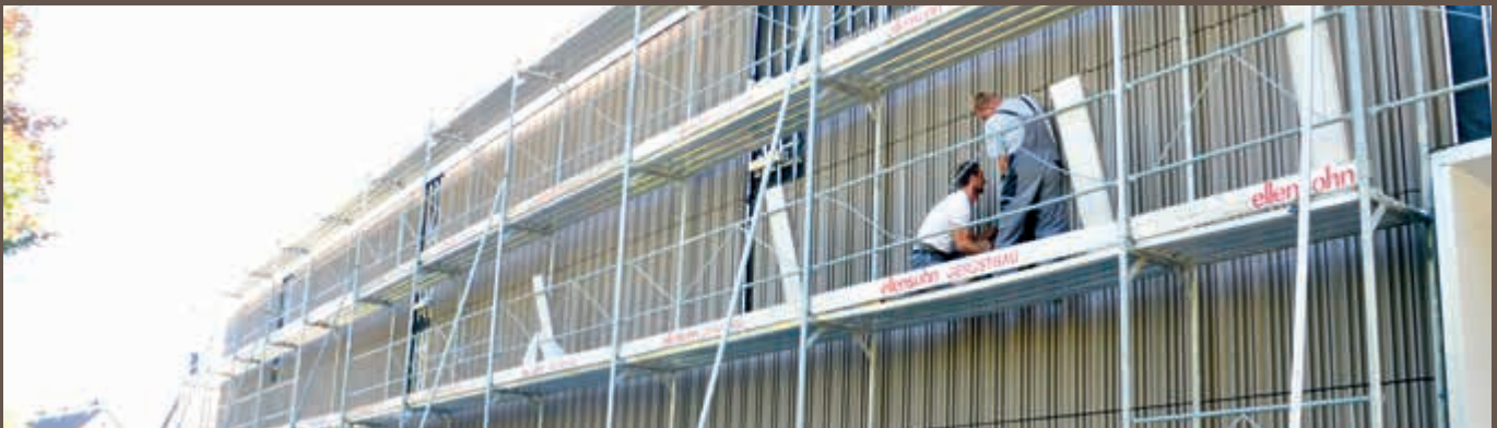
Montage der Fassade
