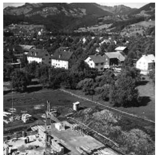
Für die Kinder der Südtiroler-Siedlung (Bildmitte) lag die neue Schule unmittelbar vor der Haustüre.
