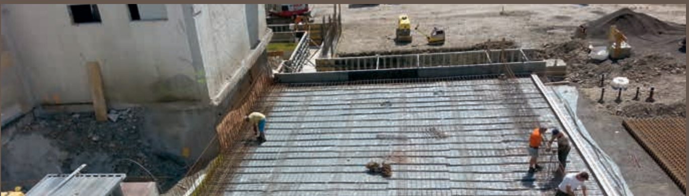
Bodenplatte
