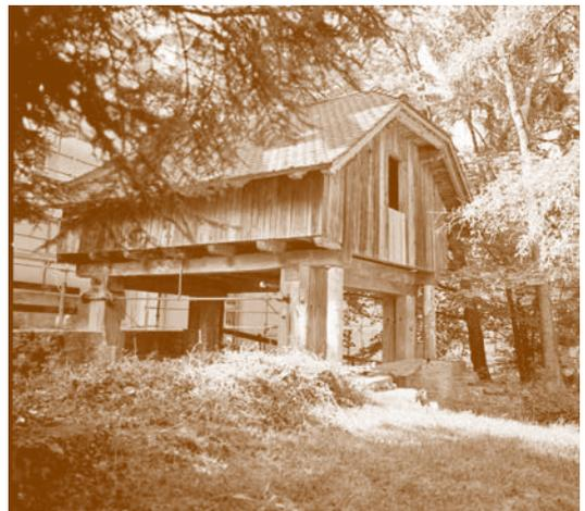
Die „unteren Läden“ neben der Spinnerei Rhomberg (jetzt Gewerbepark Rankweil) dienen der Ableitung von Überwasser sowie der Einleitung des Notwassers für den Mühlbach.
